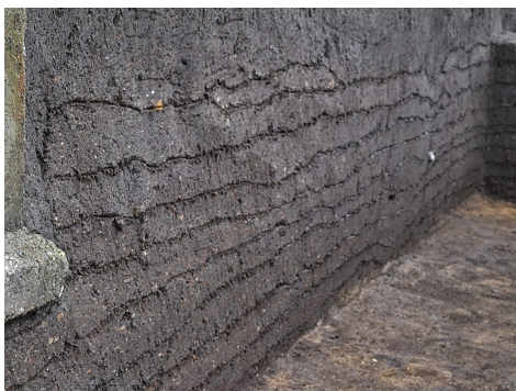
元総社蒼海遺跡群(147) (礎石建物跡 総地業断面)
